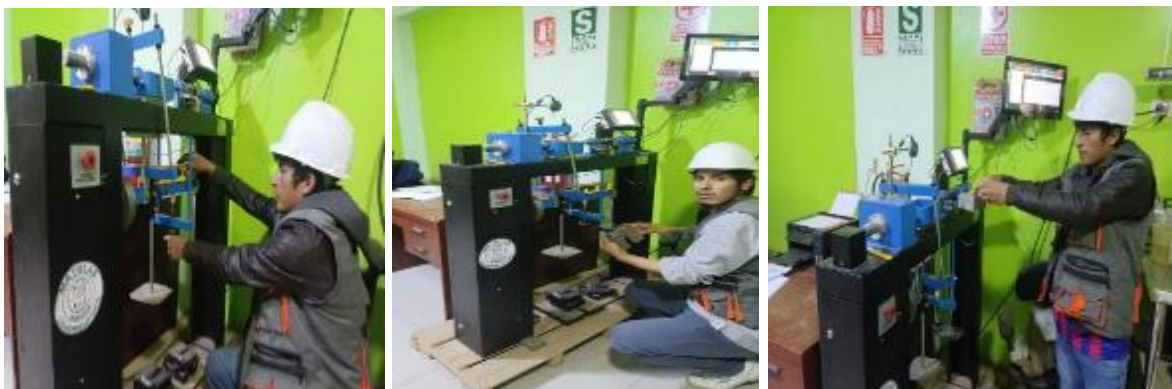
Figura 103. Colocación la caja corte
