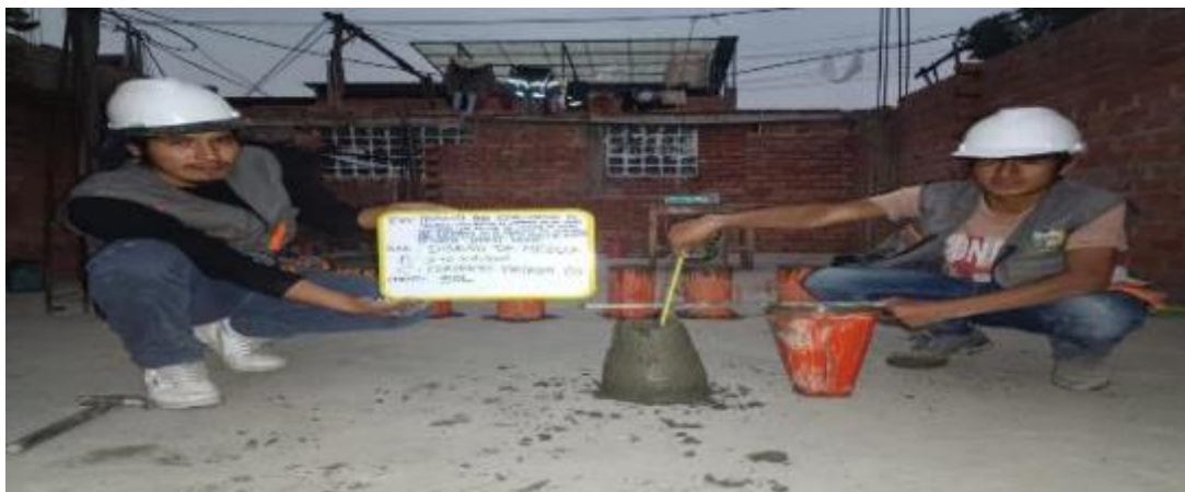
Figura 62. Prueba de revenimiento
