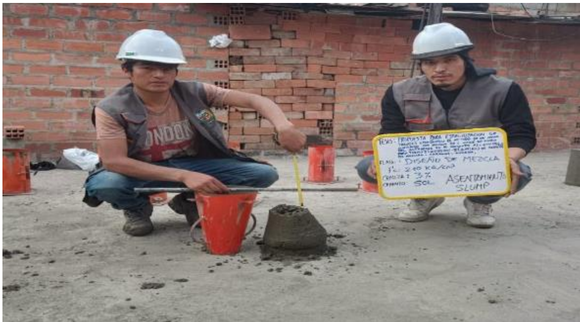
Figura 64. Prueba de revenimiento
