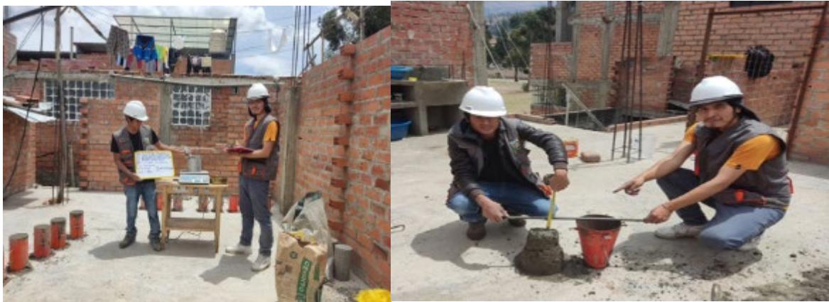
Figura 57 .Temperatura y Verificación del Slump en la mezcla
