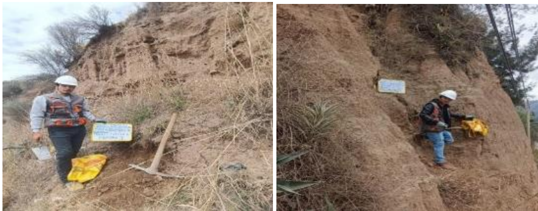
Figura 82. Ubicamos el lugar para la calicata donde será el proyecto.
