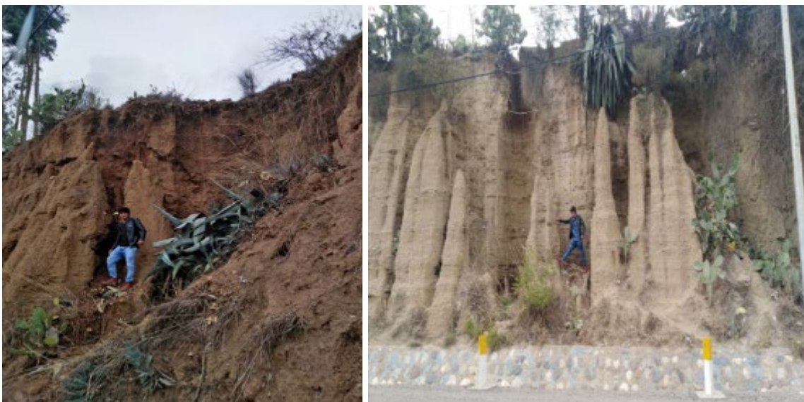
Figura 18. Lugar determinado de estudio de estabilización de talud
