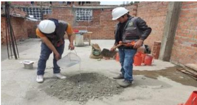
Figura 61. El proceso de mezclado del concreto
