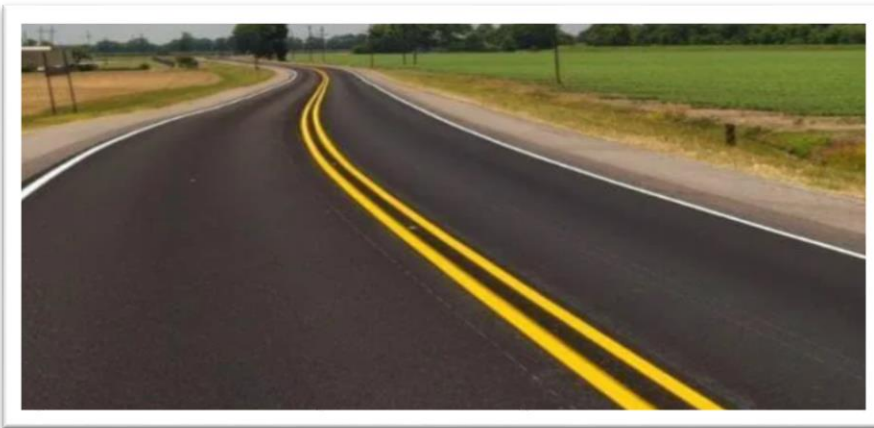
Figura 03: Los Pavimentos Flexibles.
