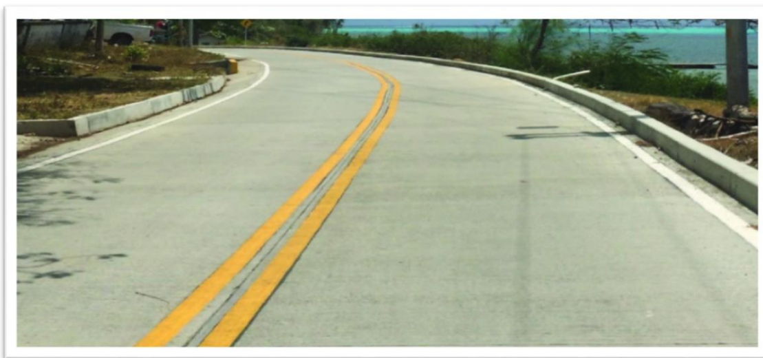
Figura 01: Pavimentos Rígidos de Concreto Simple con Juntas.
