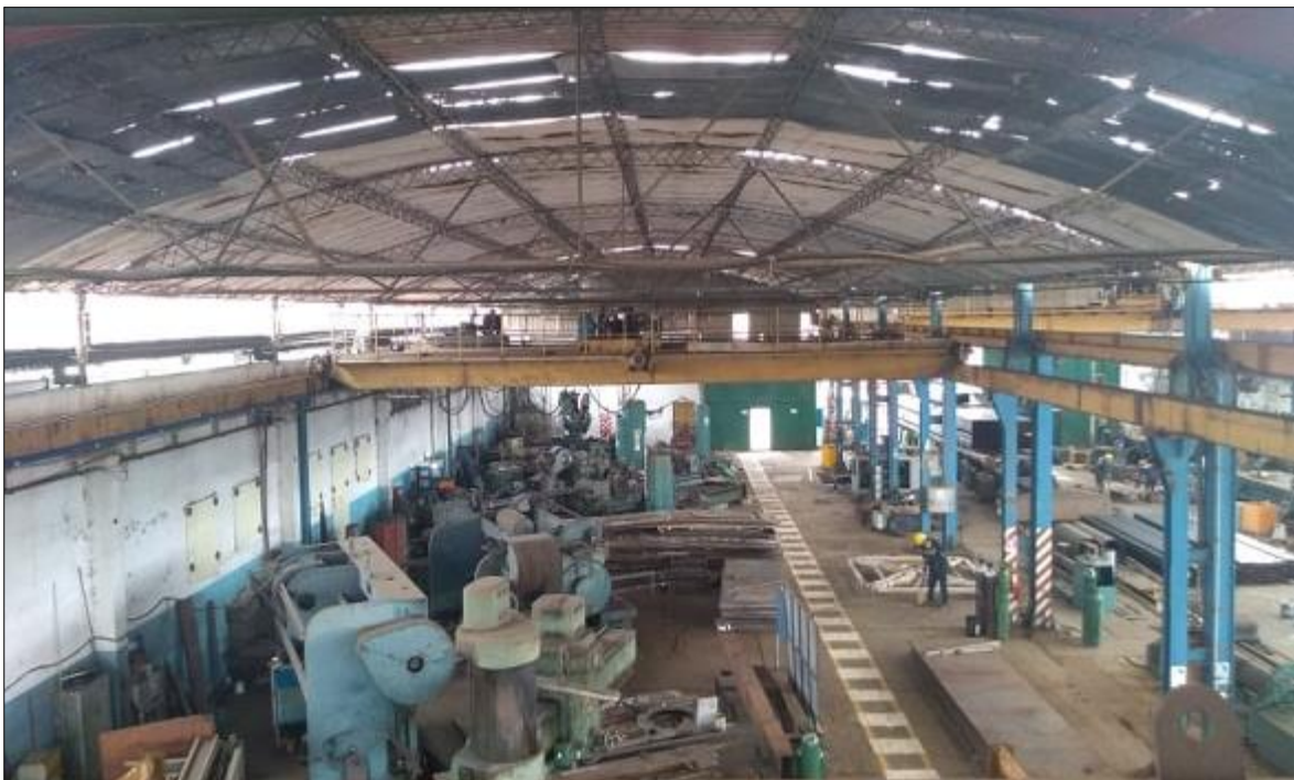
Ilustración 2: Nave de Mecanizados, Sector derecho de la Planta, COMET.
