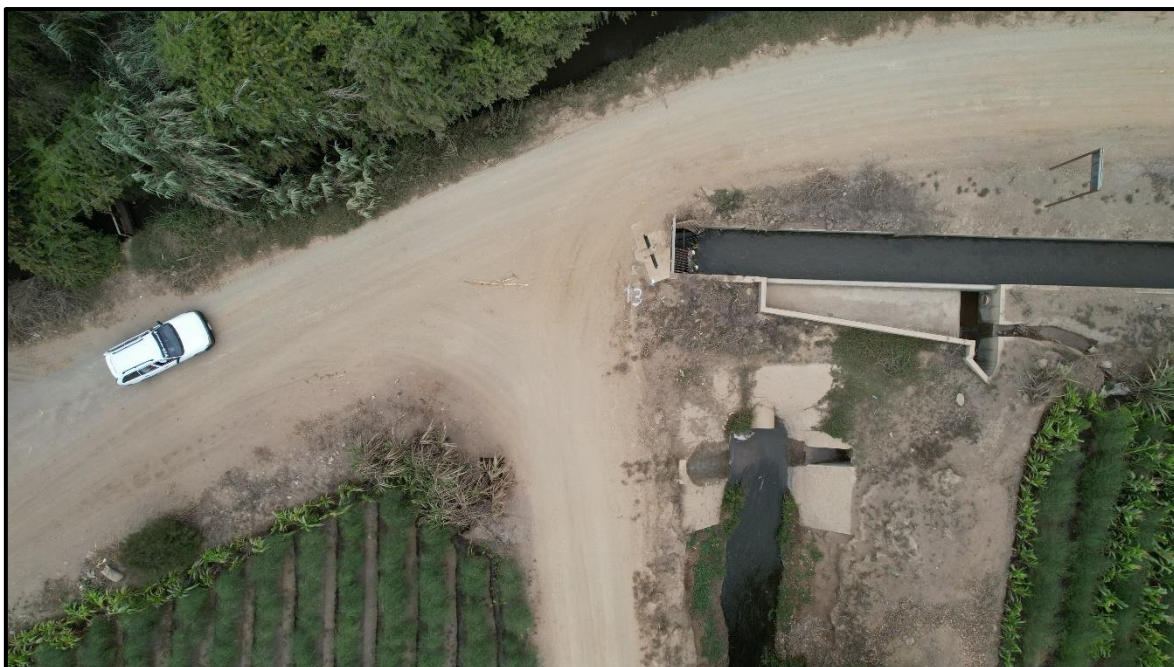
Anexo 8.2.15. Ubicación de punto de foto control N° 13 tomado con dron en tramo Huancaquito Alto-LI1153-Viru.
