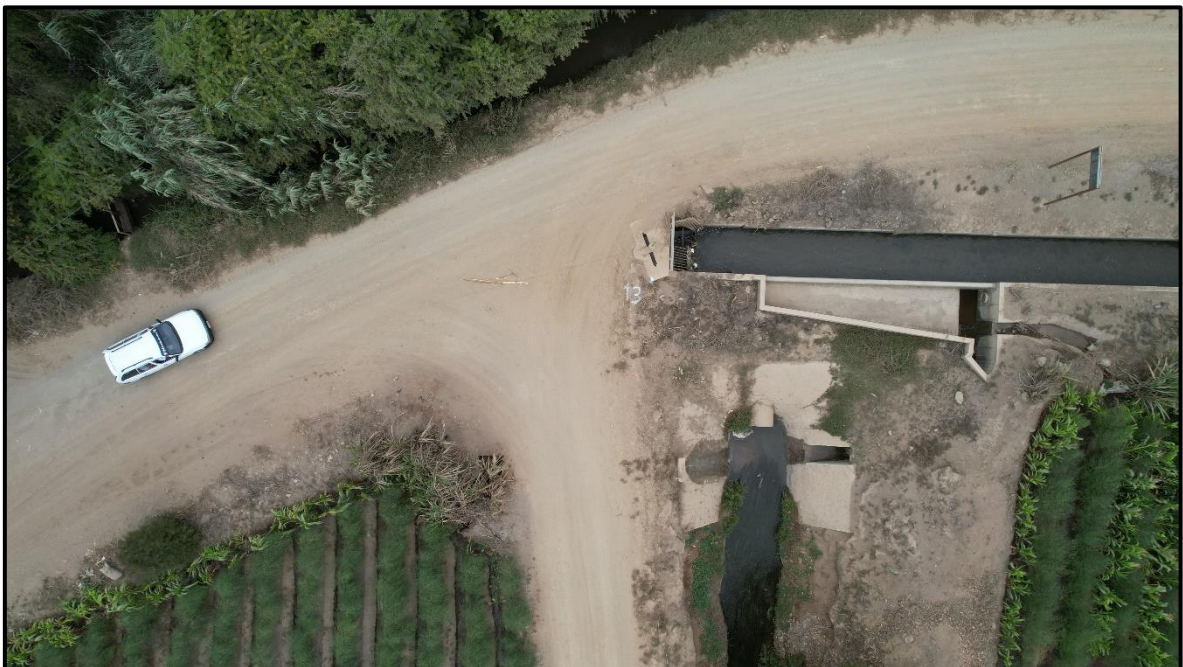
Anexo 8.2.4. Fin del tramo: Kilómetro 3+040 de tramo Huancaquito Alto-LI1153-Viru
