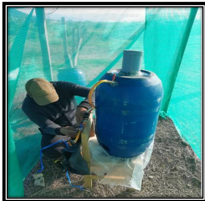
Figura N°11: Instalación del biodigestor en la caseta, dentro de las áreas libre del camal municipal de Picota.
