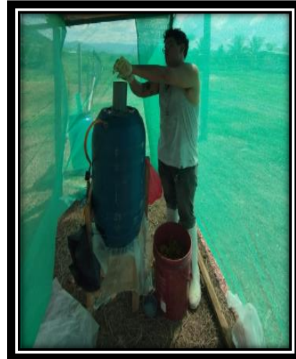
Figura N°9: Llenado del interior del biodigestor con la mezcla: estiércol, vísceras y sangre.
