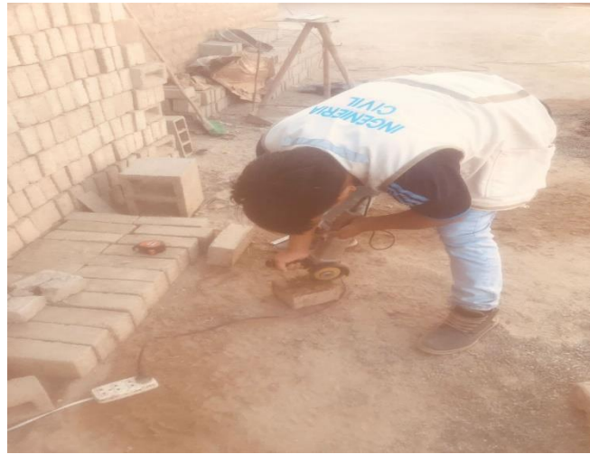
figura 52. cortando los ladrillos crudos con una moledora, para armar murete
