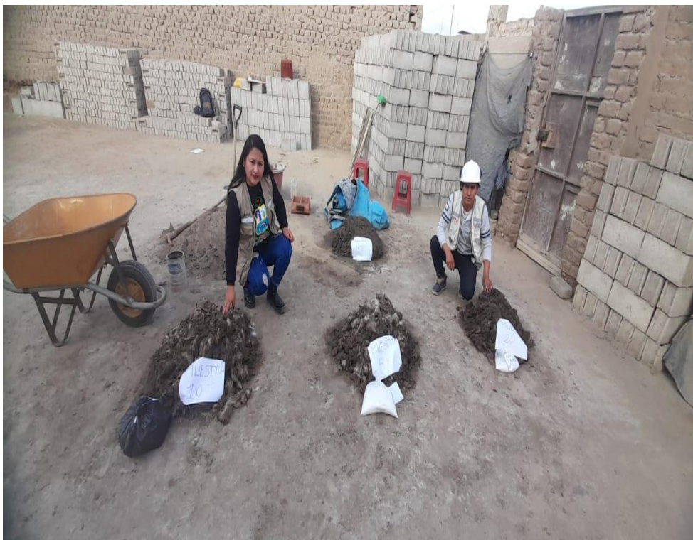
figura 31. Incorporación de cal a la mezcla de barro después de reposar por 24 horas.
