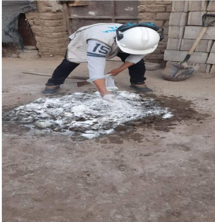
figura 32. Incorporación de la cal a la mezcla de barro antes del moldeo.
