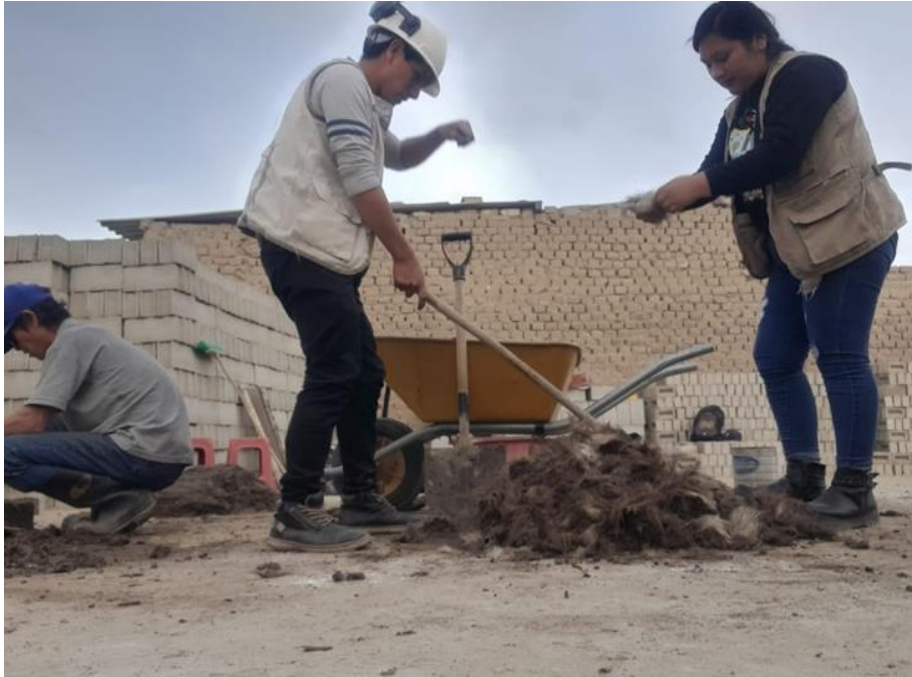
figura 30. Incorporación de la fibra sintética de polietileno a cada porcentaje
