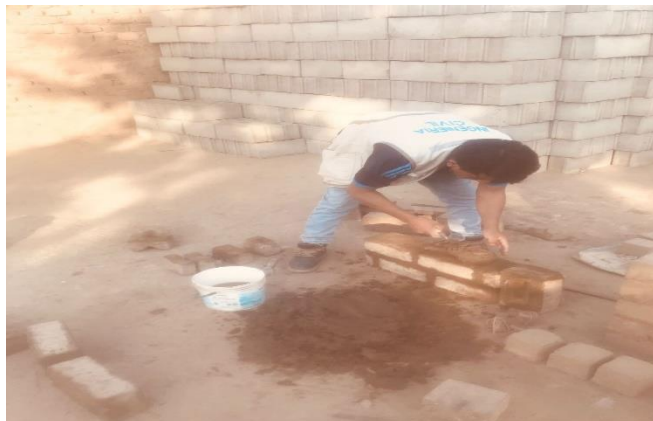
figura 53. Asentando ladrillo para murete
