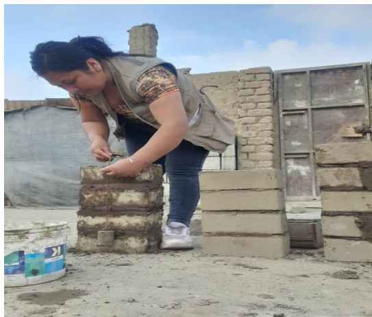
figura 55. Aplomando la pila
