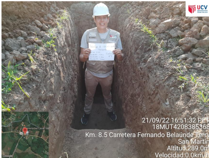
ANEXO N°4: Excavación de la Calicata en el Zona de Investigación.
