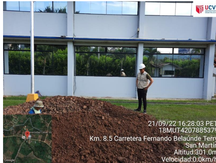
ANEXO N°2: Excavación de la Calicata en el Zona de Investigación.
