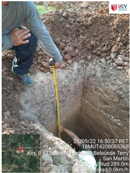
ANEXO N°5: Verificación de la Calicata.
