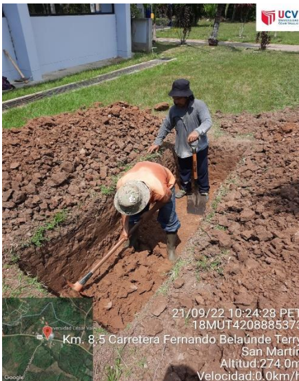
ANEXO N°1: Excavación de la Calicata en el Zona de Investigación.
