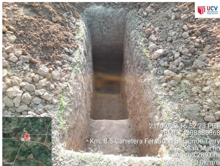
ANEXO N°6: Verificación de la Calicata.
