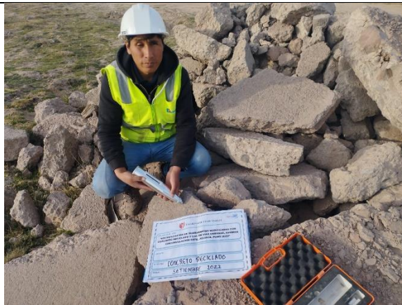
Fotografía 5. Medición de resistencia con el esclerómetro.
