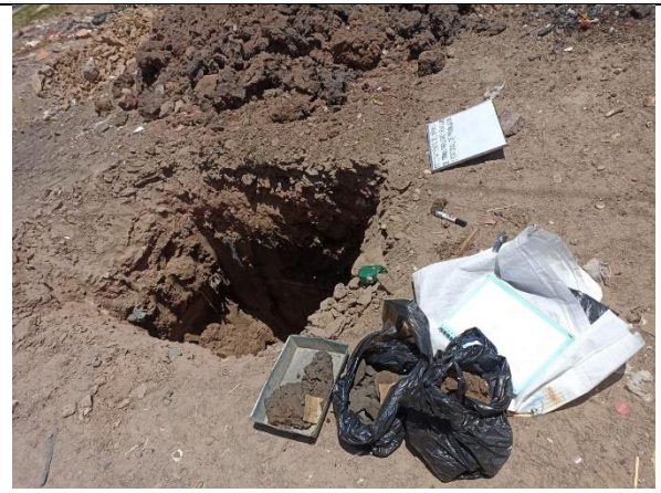
Fotografía 2. Excavación de calicatas
