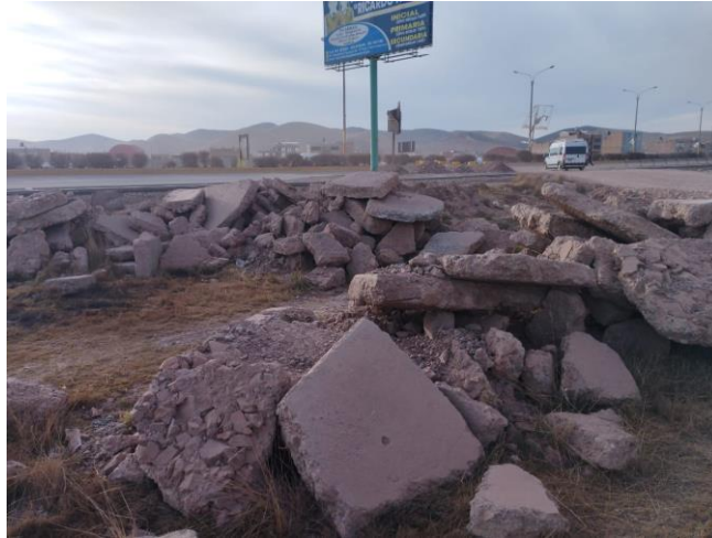
Figura 6. Desechos de concreto de pavimento rígido
