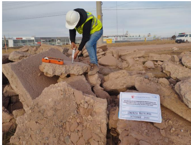
Figura 7. Medición de la resistencia del concreto reciclado con el esclerómetro
