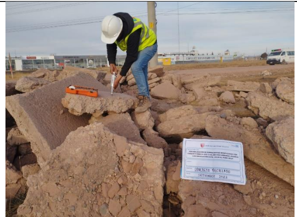
Fotografía 4. Medición de resistencia con el esclerómetro
