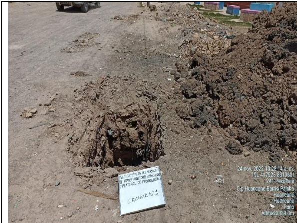
Fotografía 1. Excavación de calicatas
