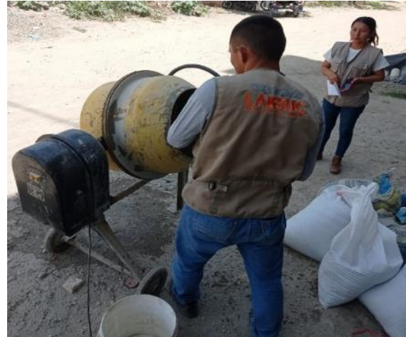
Foto 18: Preparación de mezcla para adoquines
