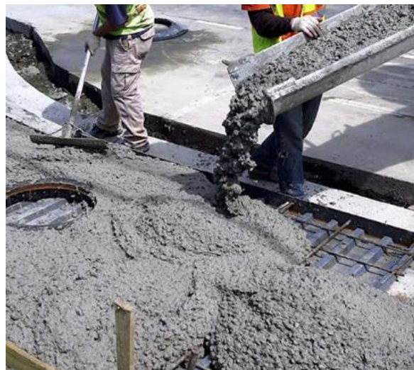
Figura 1. Concreto en estado fresco.
