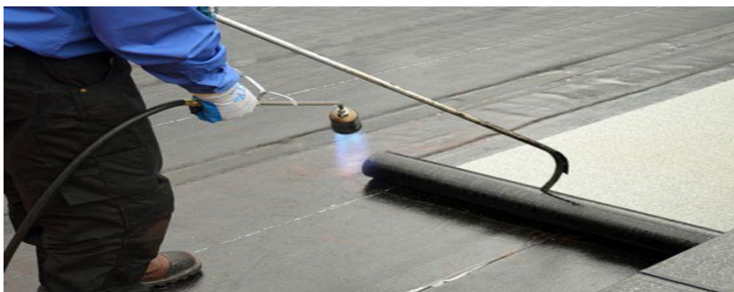
Figura: Proceso de Impermeabilización de un techo. Recuperado: https://www.pinterest.es/pin/616500636476137324/
