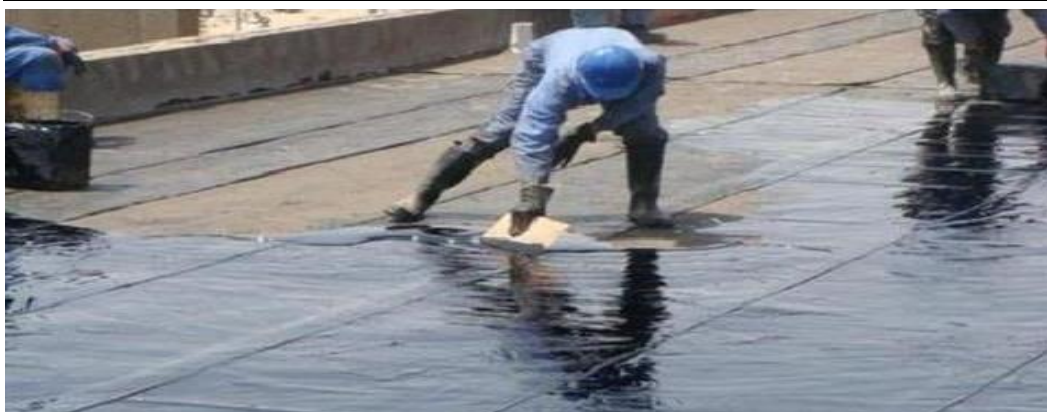
Figura: Proceso de Impermeabilización. Recuperado: https://www.pinterest.es/pin/66498470122988796
