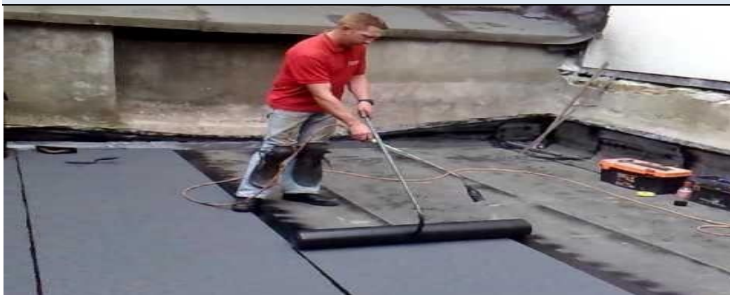
Figura: Proceso de impermeabilización. Recuperado: https://www.pinterest.es/pin/664984701232975
