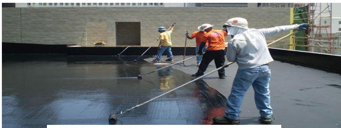
Figura: Impermeabilización de un techo. Recuperado: https://www.pinterest.es/pin/52994708114754559
