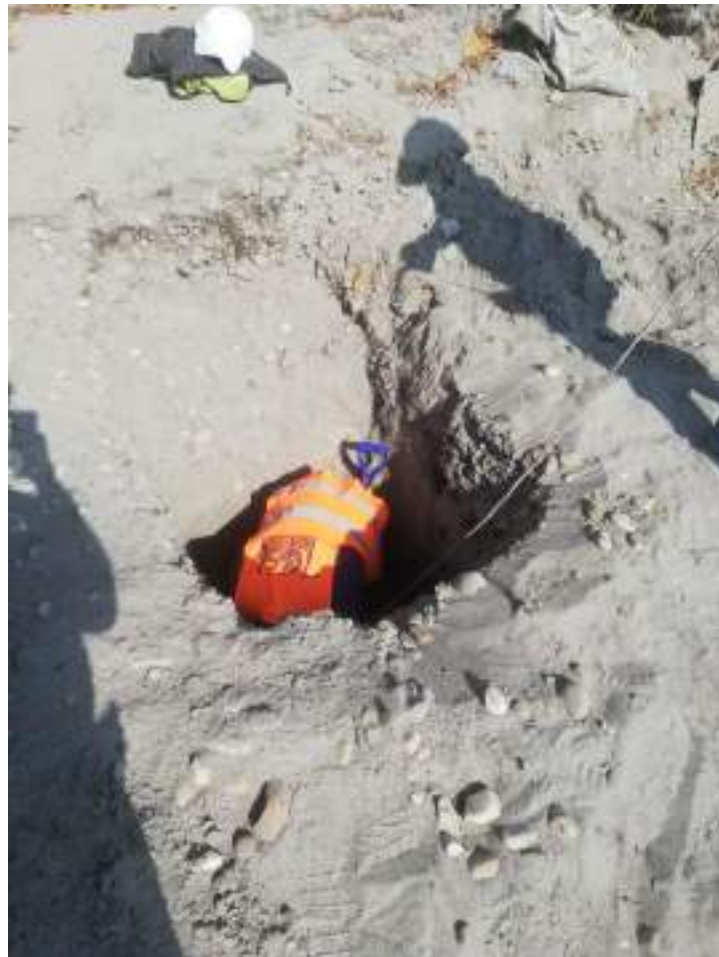
Figura 71. Se observa la realización de la calicata
