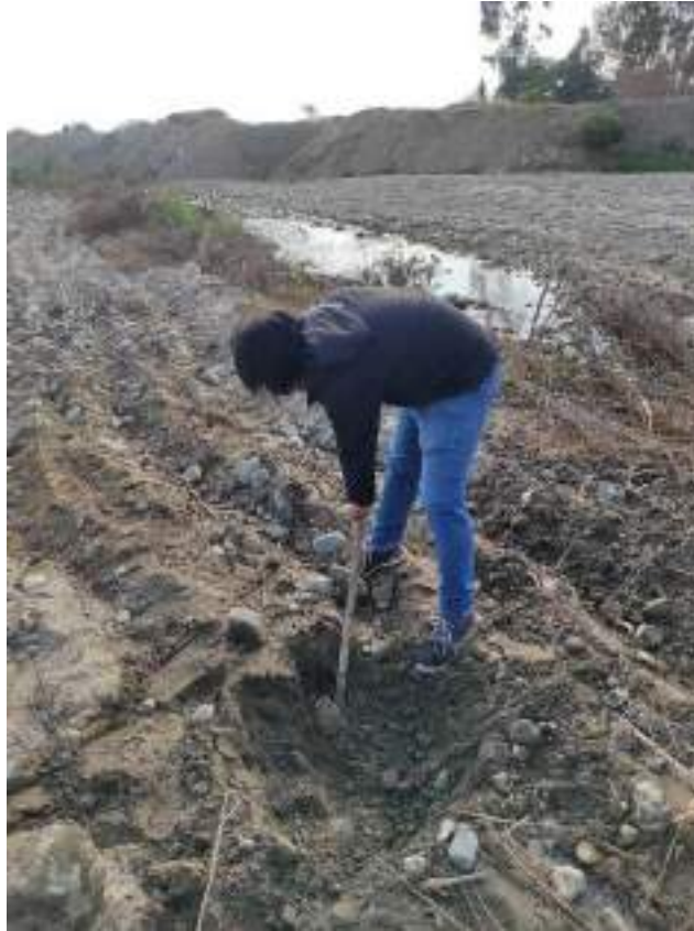
Figura 68. Se continúan realizando las calicatas en zona de estudio
