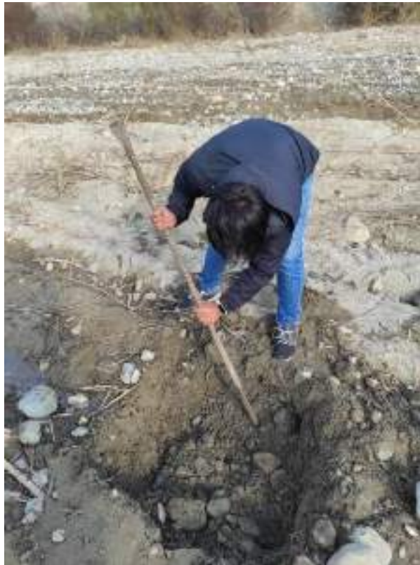
Figura 66. Se visualiza la realización de las calicatas en la zona de estudio
