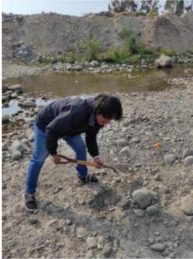
Figura 74. Se observan los trabajos de realización de calicatas
