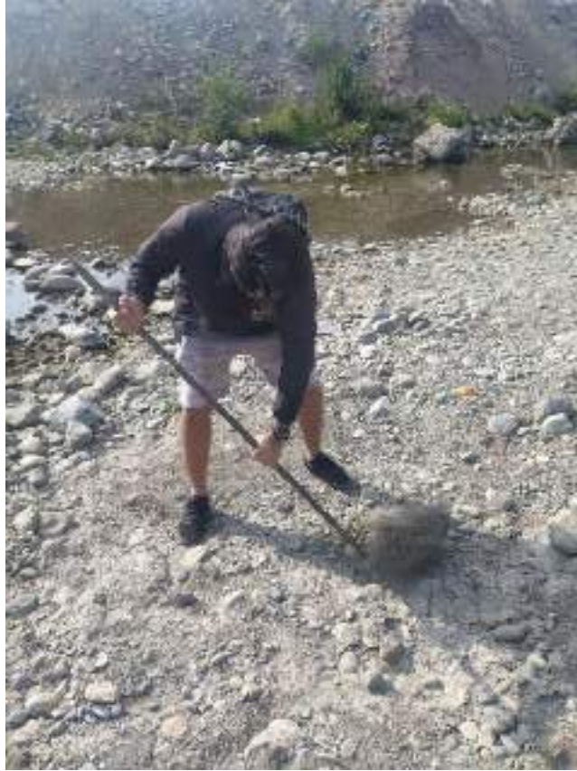
Figura 72. Se continúan realizando los trabajos de calicatas
