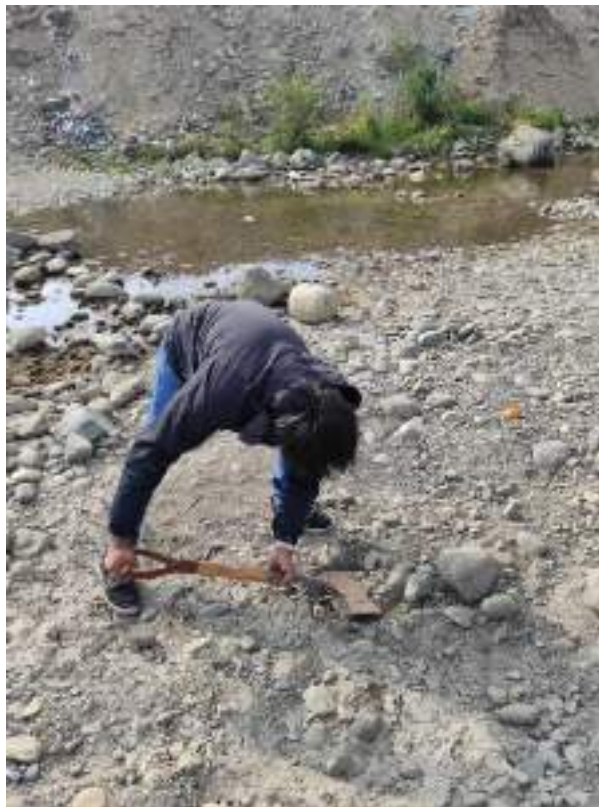
Figura 69. Se realiza calicatas en zona de estudio.
