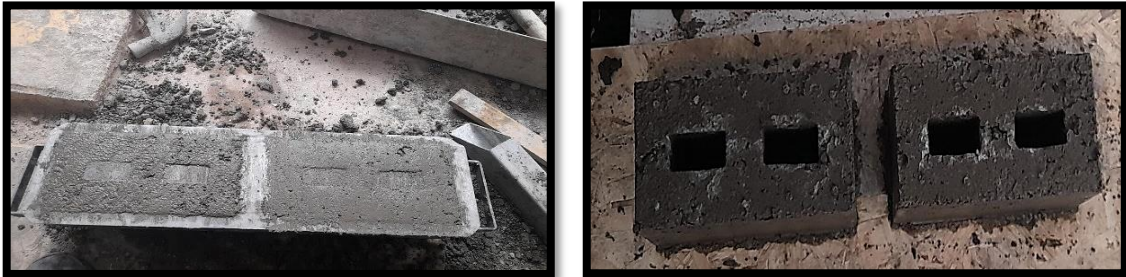
Figura 14. Moldeado de los bloques de concreto. (Fuente: Elaboración Propia).
