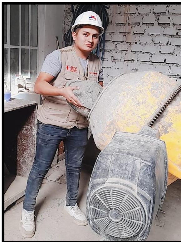
Figura 13. Mezclado del concreto. (Fuente: Elaboración Propia).
