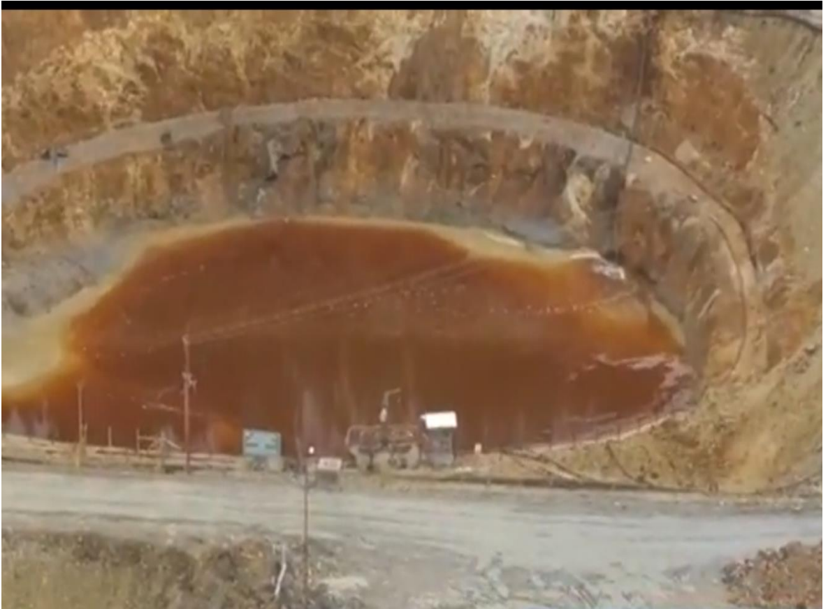
Pozo de oxidación de la minera Quiruvilca, sin tratamiento.
