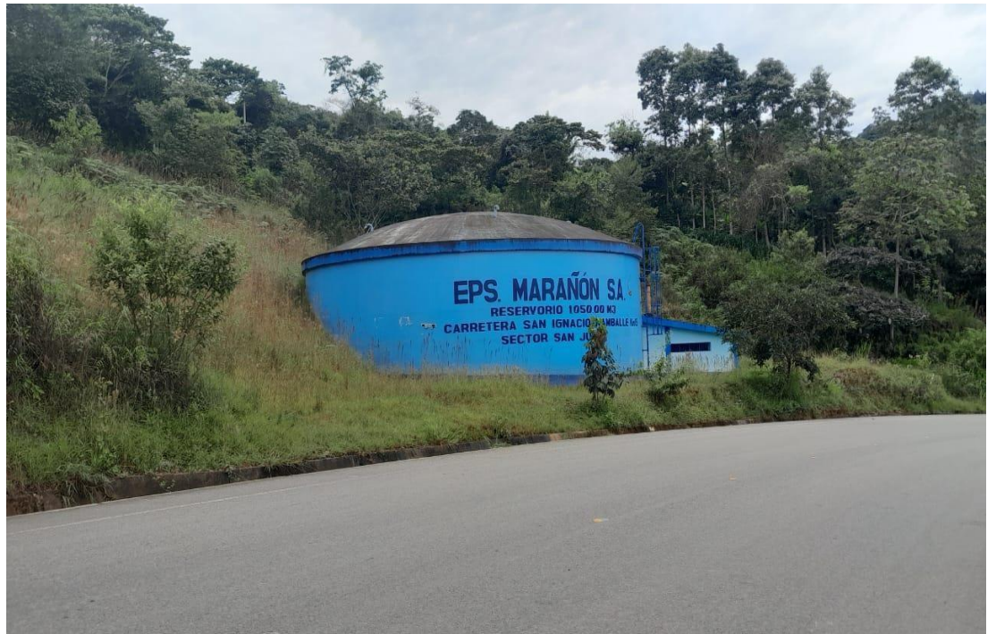
Figura 13. Reservorio de 1050 m 3 de forma circular.
