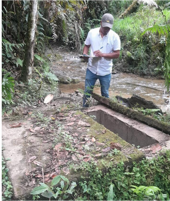
Figura 9. Realizando el diagnostico a la línea de conducción.
