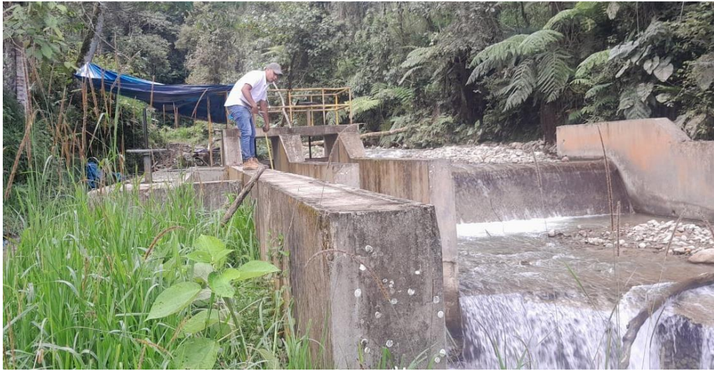
Figura 7. Realizando el diagnóstico de la captación.
