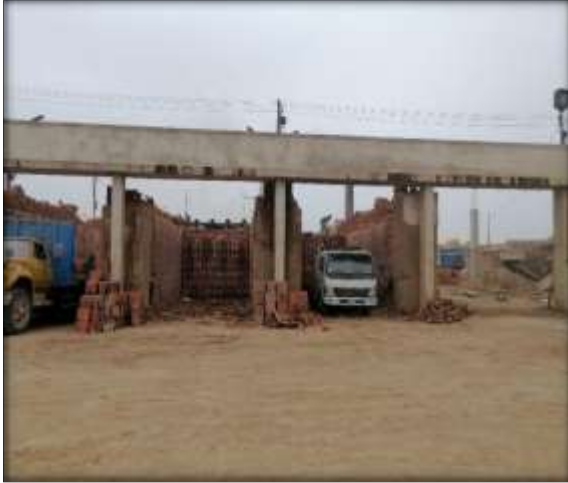
Foto N ° 01: Visita a la Ladrillera Cerro Azul para la elaboración de los ladrillos.
