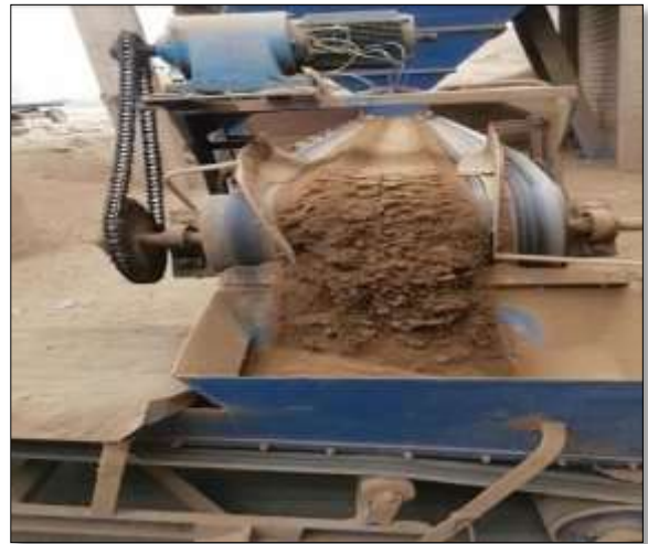
Foto N ° 04: vista de la máquina de la incorporación de la cascarilla de arroz
