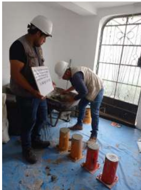
Figura 26: Llenado de probetas de control para ensayo de resistencia a la compresión.
