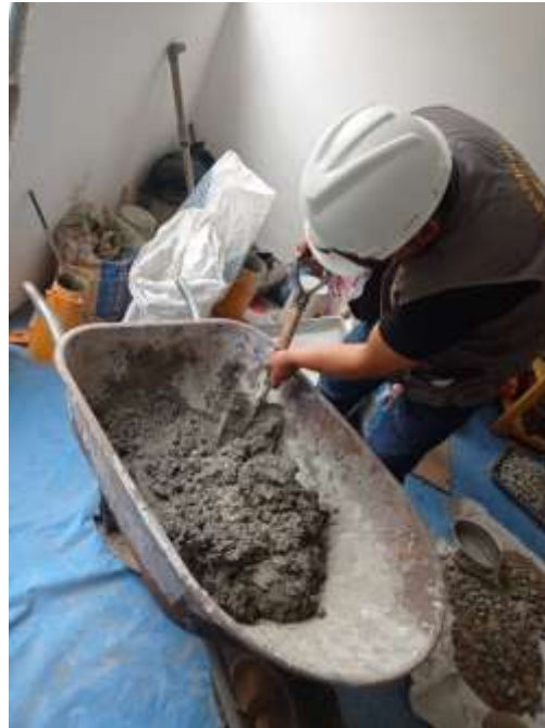
Figura 19: Proceso de mezclado del concreto adicionando CME al 9%.
