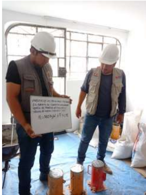
Figura 25: Llenado de probetas de control para ensayo de resistencia a la compresión.
