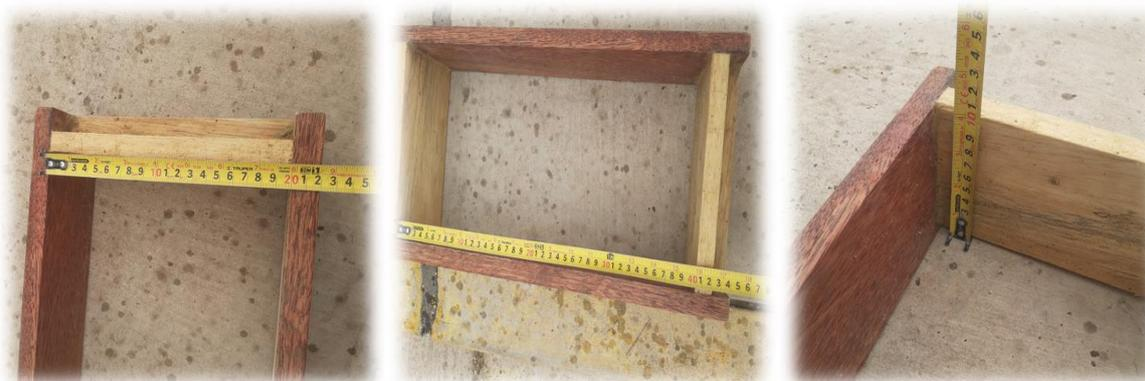
*Ilustración 11. Elaboración de moldes de madera para adobe.*
