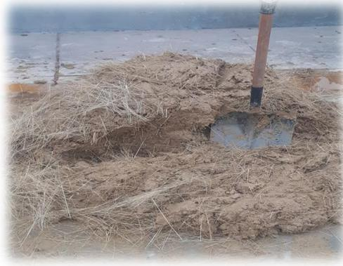
*Ilustración 13. Preparación de la mezcla de adobe.*
