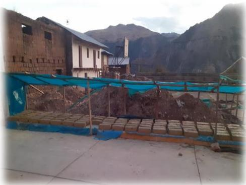
*Ilustración 15. Proceso de secado de los adobes.*
