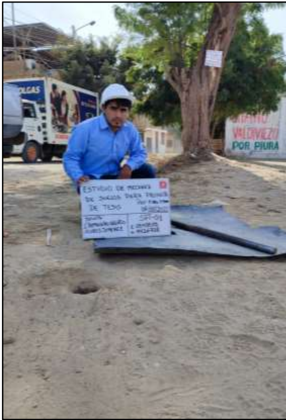
Descripción: Ensayo SPT, en sondeo "SPT-1" 1-1.45 m 01 Foto N°
