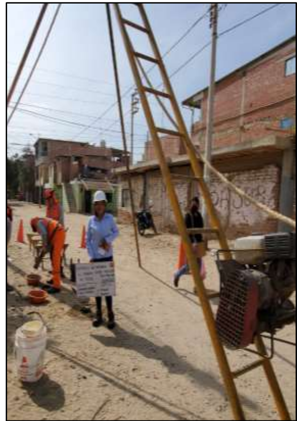
Descripción: Ensayo SPT, en sondeo "SPT-2" 1-1.45 m 02 Foto N°
