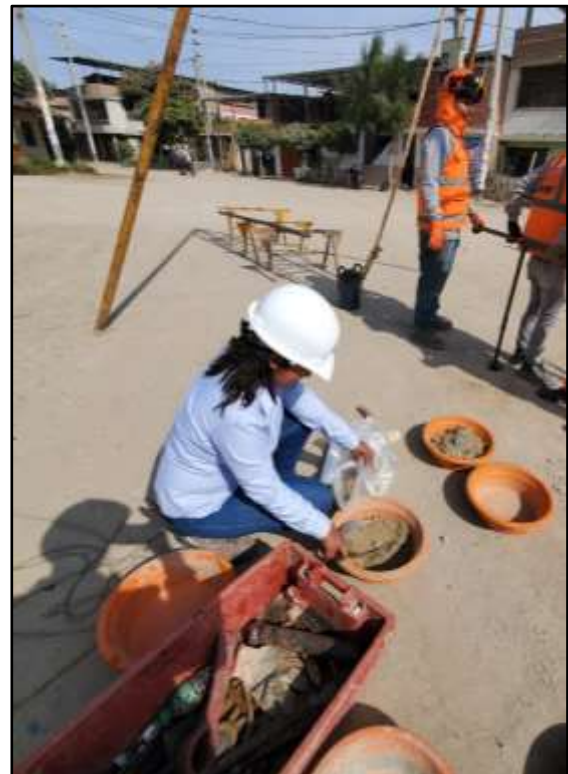
Descripción: Toma de muestras por cada metro Ensayo SPT, en sondeo "SPT-2" 08 Foto N°
