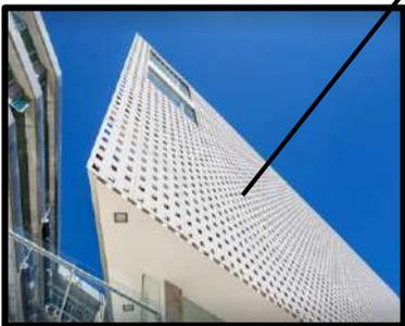
• La materialidad del edificio complementa su concepto, las fachadas que colindan con las vías están revestidas por una malla metálica, genera un elemento de transición visual y sensorial.
