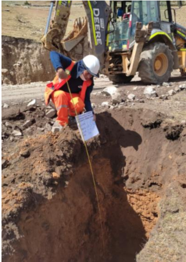
Figura 10. calicata 01 prog. Km 2+120.
