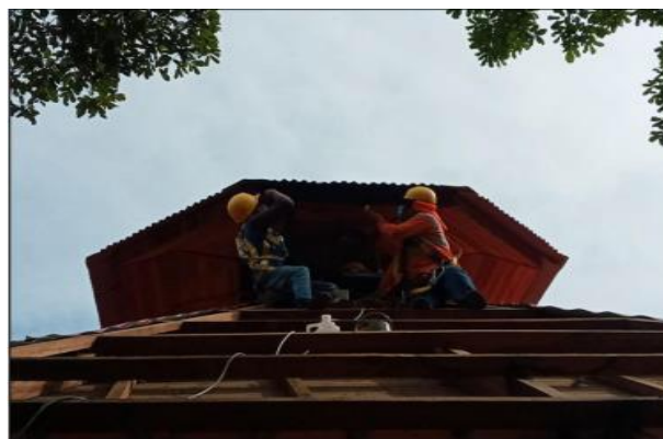
Figura 9. Trabajos del personal en altura con sus EPPs
