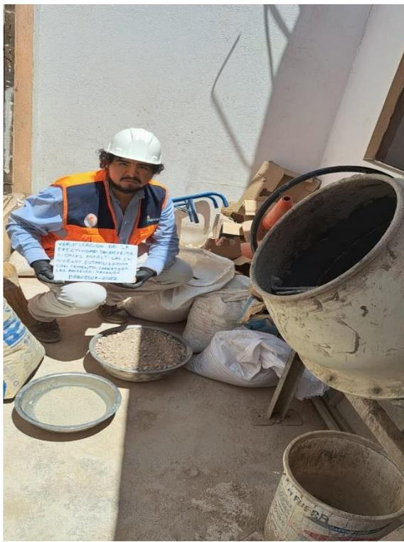
Figura 19. Preparación de suelo cemento. Fuente: Propia.
