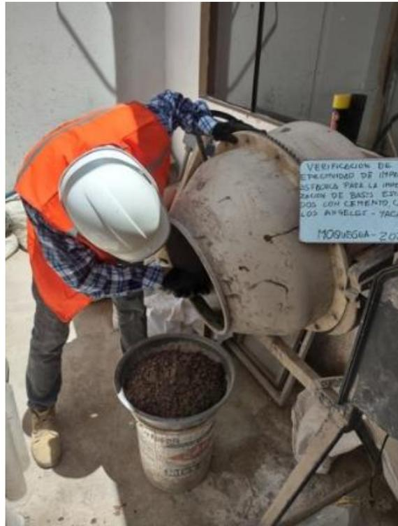
Figura 20. Preparación de suelo cemento. Fuente: Propia.
