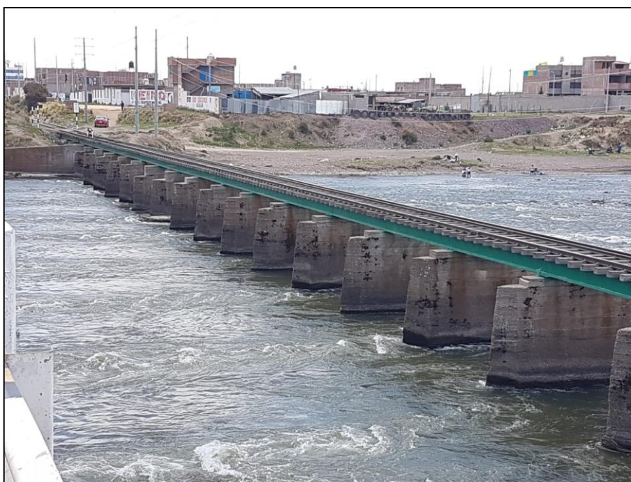
Figura 1. Estructura de concreto que soporta los rieles del tren en el rio maravillas – Juliaca.
