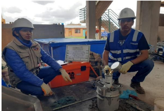
Ensayo de contenido de aire presente en el concreto fresco
