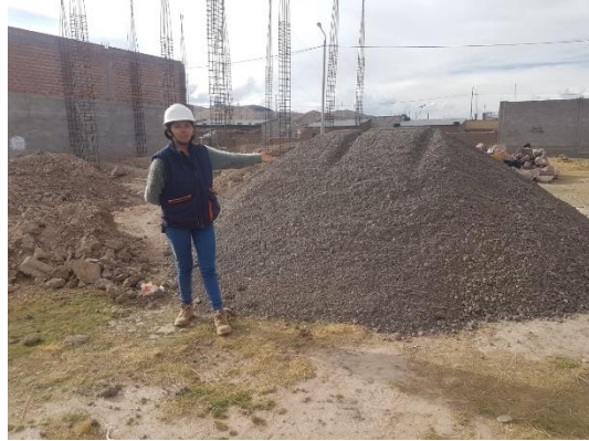
Selección del material mediante el cuarteo
