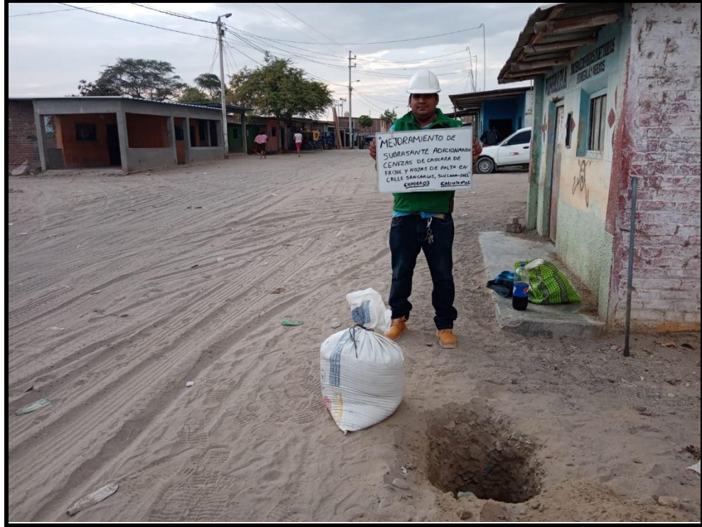
Figura 10. Calicata en sitio C-02
