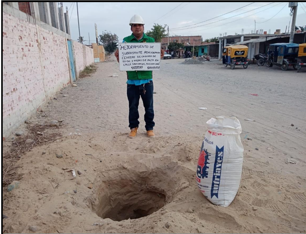
Figura 11. Calicata en sitio C-03
