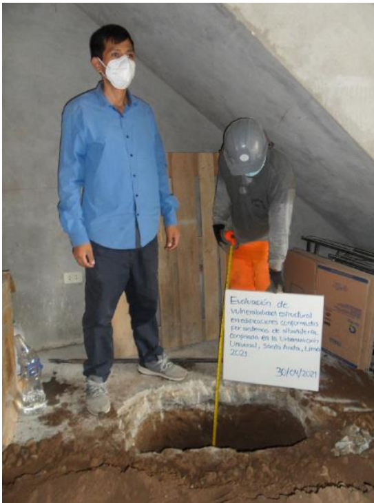
Figura 52: Proceso de excavación
