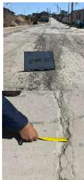
**Foto N° 02:** Avenida Arequipa, Calacoa e identificación de grietas y fisuras en el pavimento rígido
