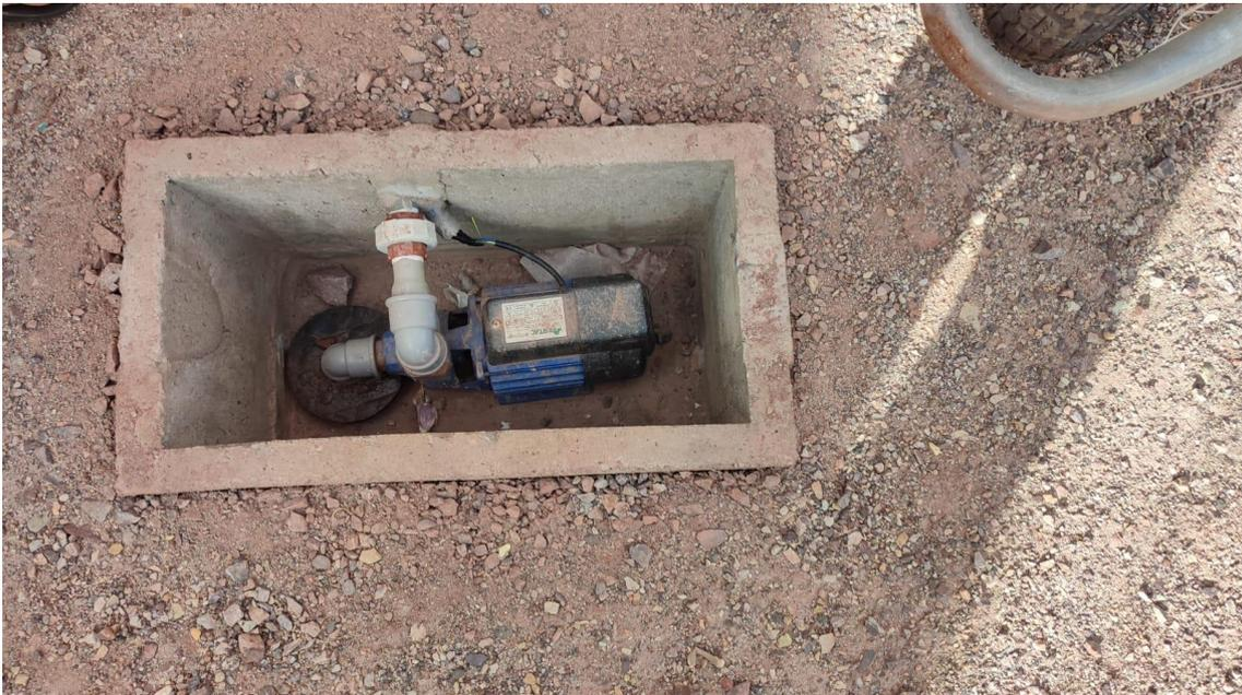
Figura 20. Bomba de agua conectada a la capa freática.
