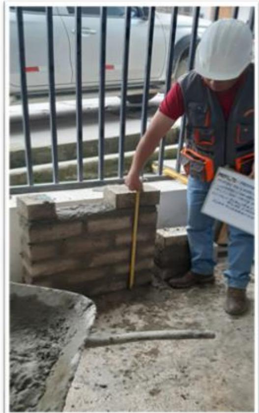
Evidencias fotográficas 30 y 31: adición de SikaCem Acelerante PE a la mezcla del mortero y elaboración de primas y muretes.
