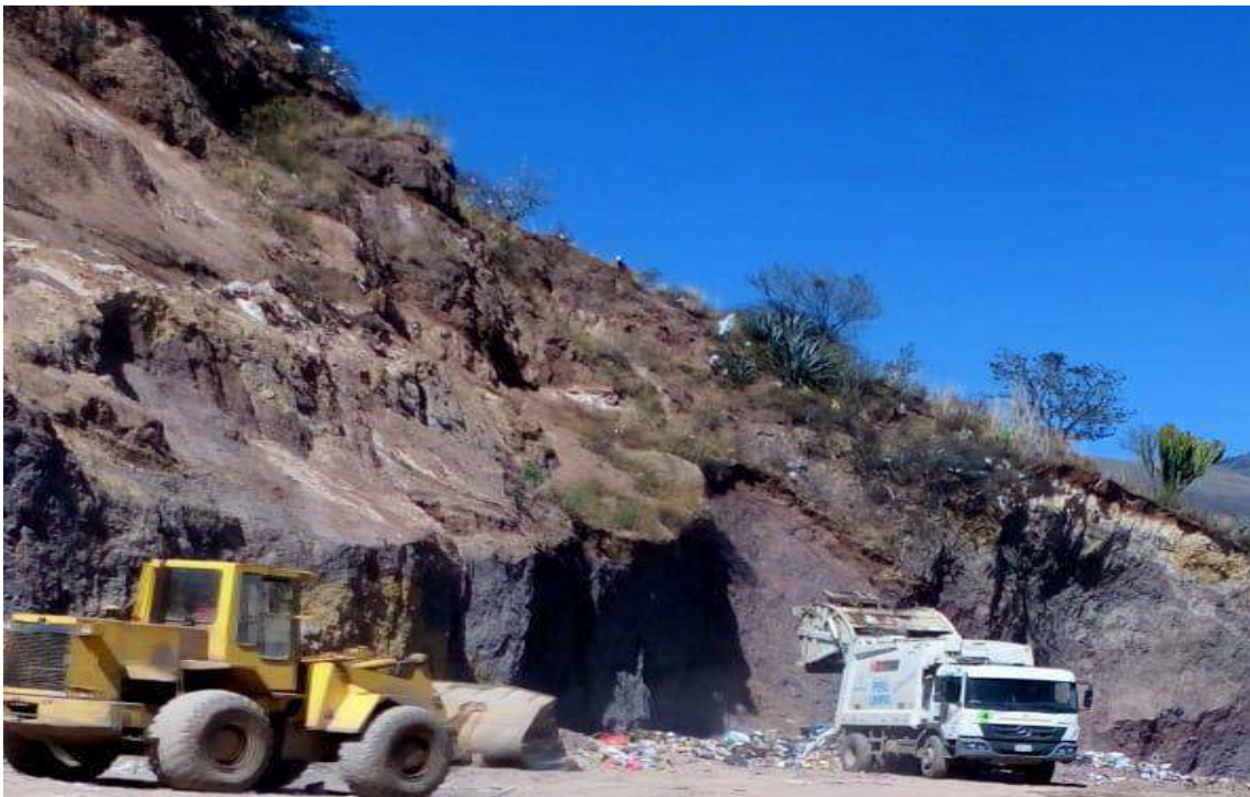
Fotografía 4: Finalmente los residuos sólidos son enterrados sin ninguna selección o tratamiento.
