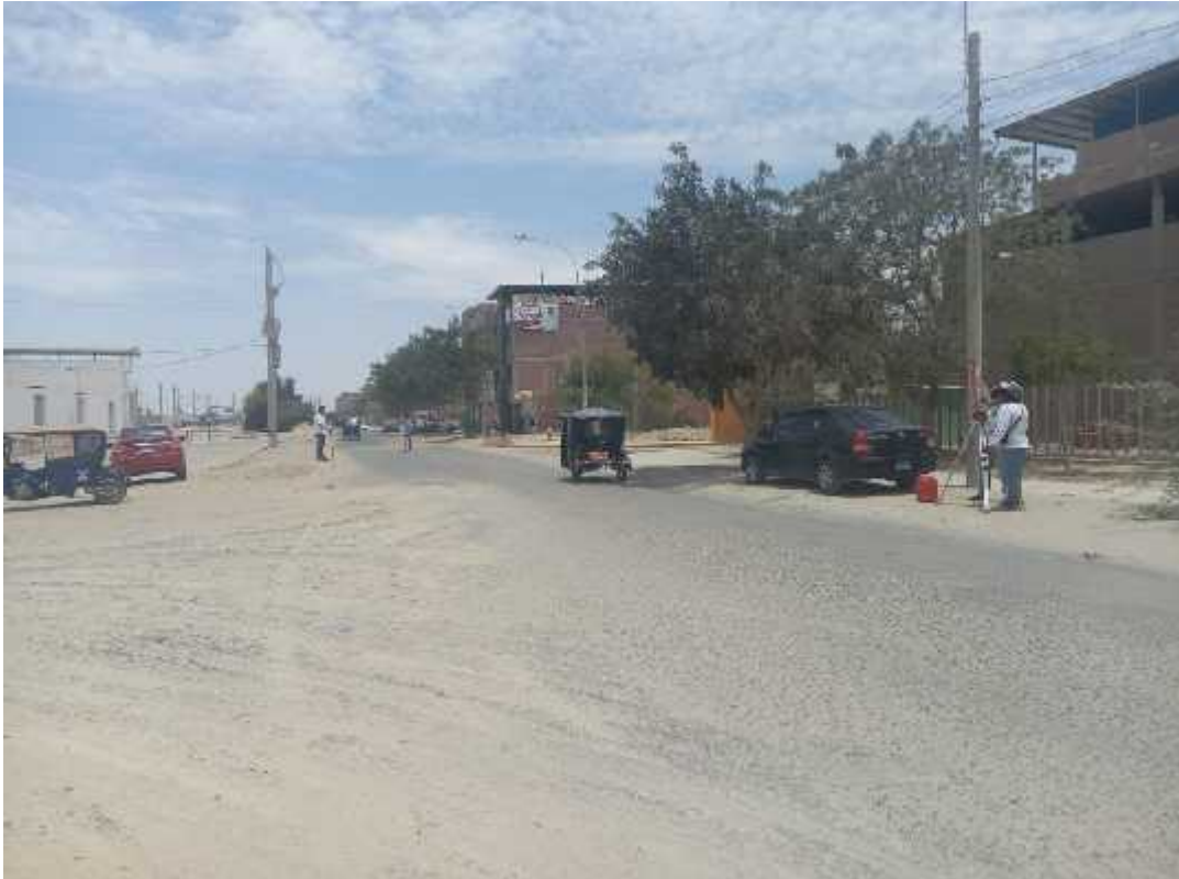
FIGURA N°9: Levantamiento topográfico en la Av. Integradora Norte y accesos.
