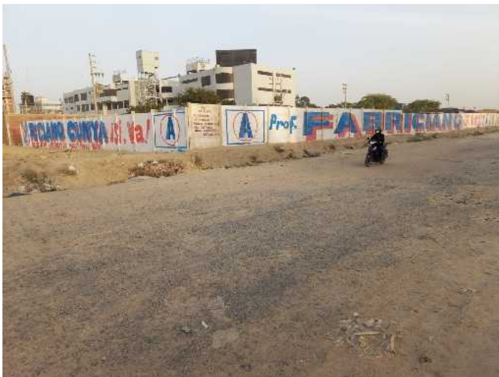
FIGURA N°2: Dren donde desfogon las aguas de la Av. Integradora Norte.
