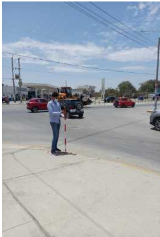
FIGURA N°4: Punto 1.0 de levantamiento topográfico en la Av. Integradora Norte.
