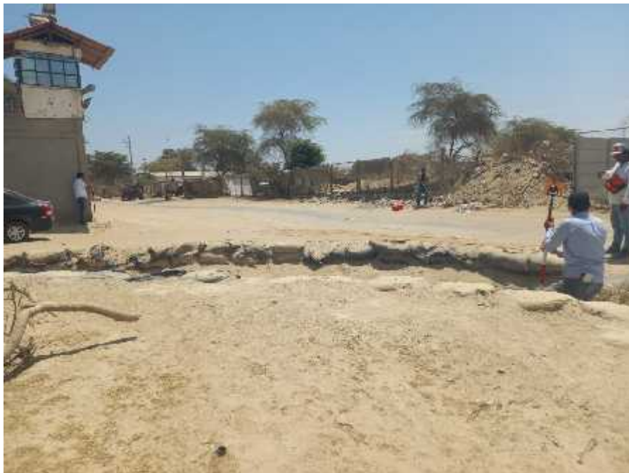
FIGURA N°8: Levantamiento topográfico en Dren Petroperú que conecta con la Av. Integradora Norte.
