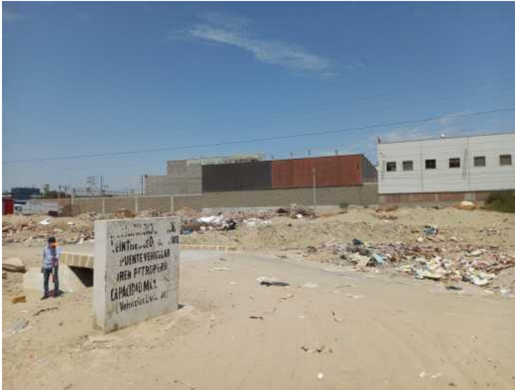
FIGURA N°7: Levantamiento topográfico en una de las alcantarillas del Dren Petroperú que conecta con la Av. Integradora Norte.
