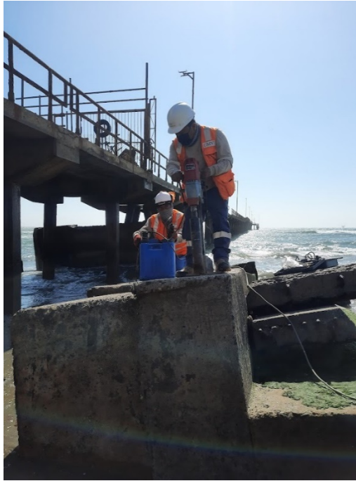
Descripción: Extracción de testigo para ensayo de diamantina.
