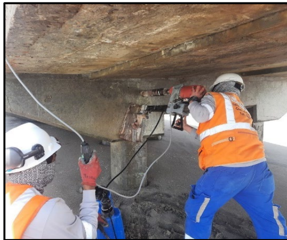
IMAGEN 5: segundo testigo en viga
