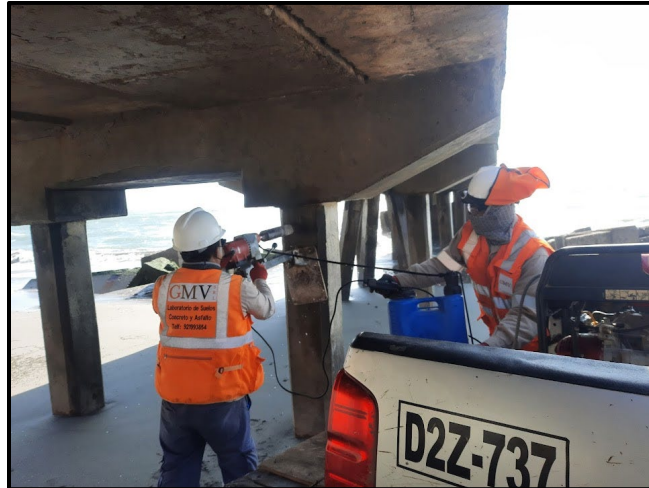
IMAGEN 6: Tercer testigo en pilote
