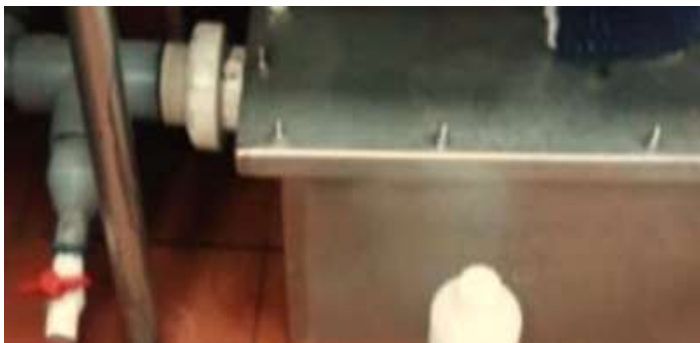
Figura 6: Proceso de instalación de trampas de grasas
