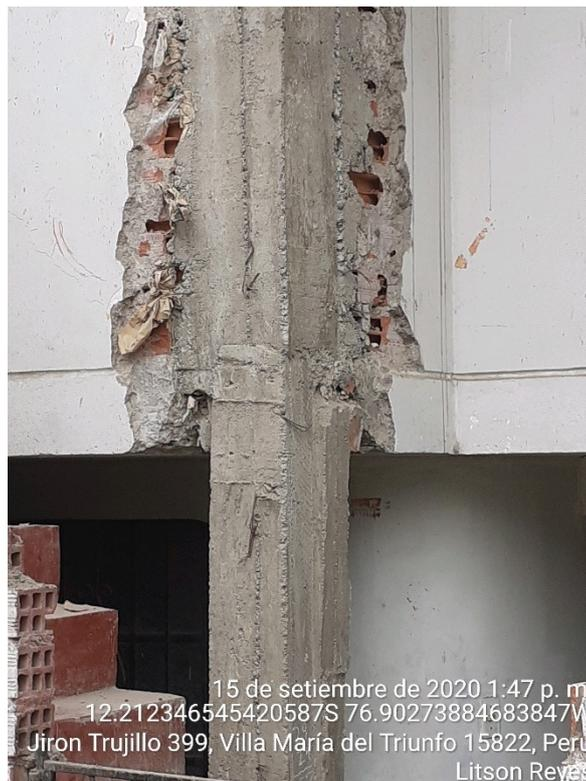
Fotografía 4. No existe un buen empalme entre la columna nueva con la viga
