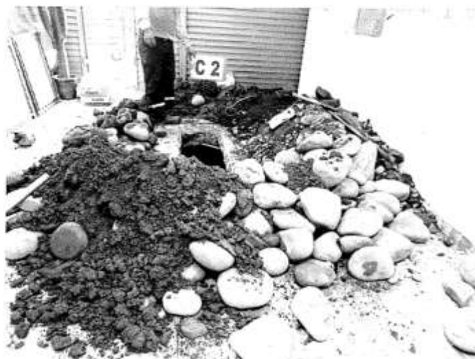
Foto N° 3.- Calicata C-2, obsérvese a los lados el material extraído.
