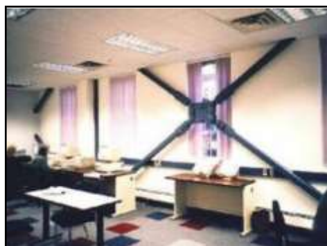
Figura 1. Disipadores por fricción.
