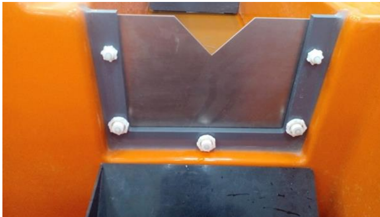
Figura 4. Instalación de vertedero.
