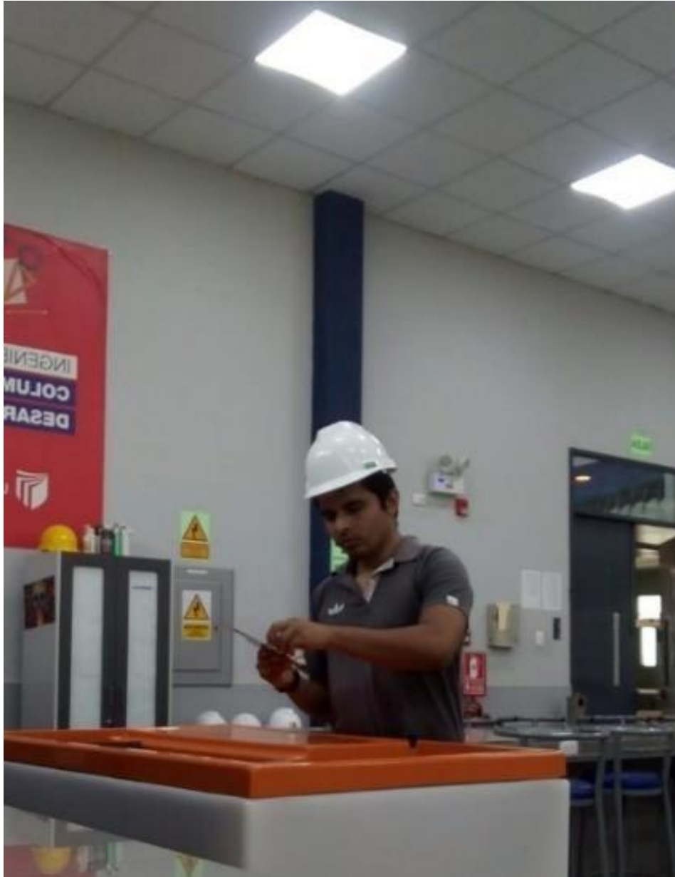
FOTOGRAFÍA 1. Instalción de elementos.
