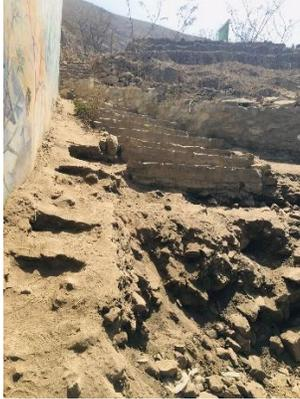
A photograph showing the same staircase in 2022, but it is completely destroyed. The concrete steps are broken and the path is a muddy, uneven dirt trail. | En estas imágenes podemos apreciar que las escaleras en 2019, se encontraba en buen estado, pero en 2022 al construir la pista, dañaron el ingreso al área natural, dejándolo ser un acceso totalmente peligroso de subir. |
