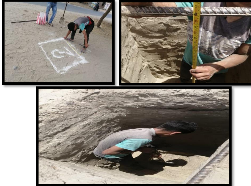
Imagen N ° 16. Excavación de calicata numero 1
