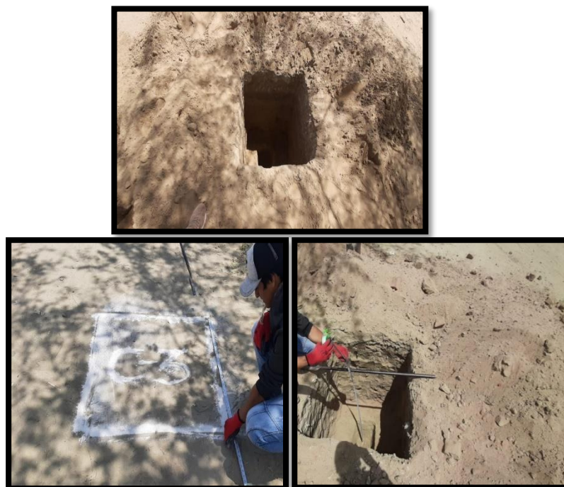
Imagen N ° 18.Excavación de calicata numero 3
