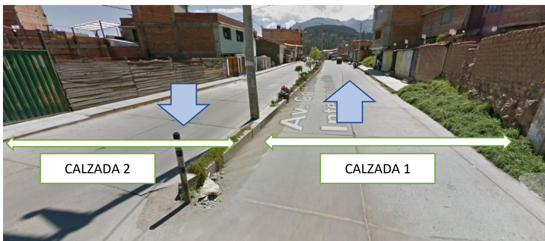
Figura 8: Se muestra una vista panorámica de la Av. Confraternidad Internacional Este, indicando el número de calzada y el sentido en el cual transitan los vehículos.
