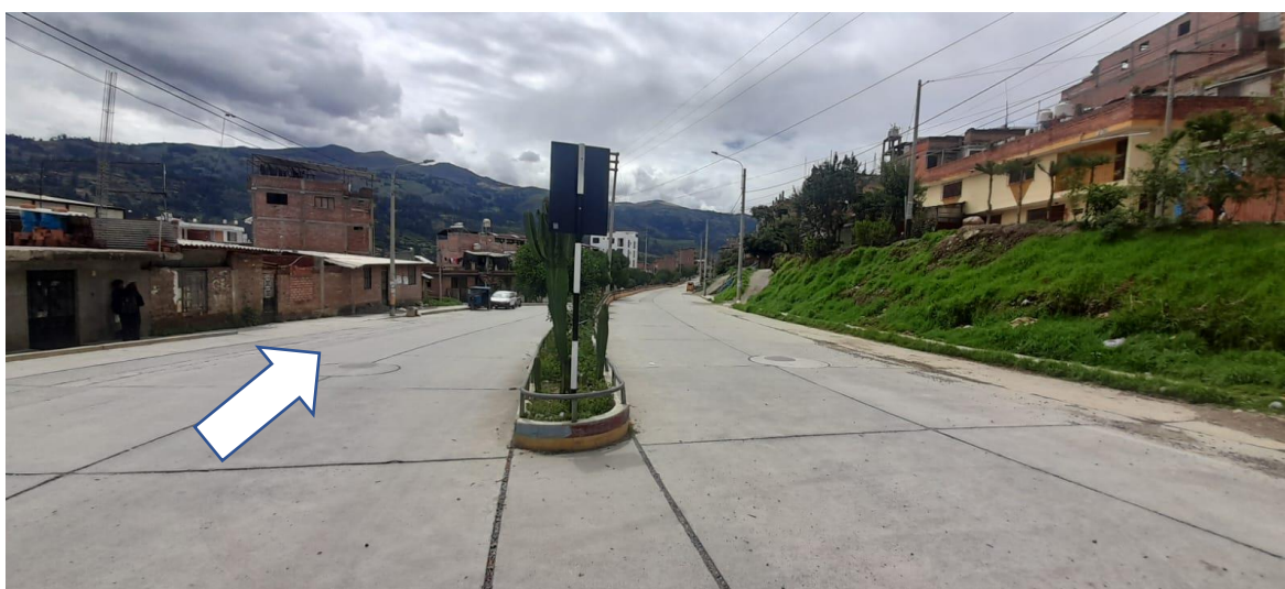
Figura 16. Inicio del desnivel para ambas calzadas
