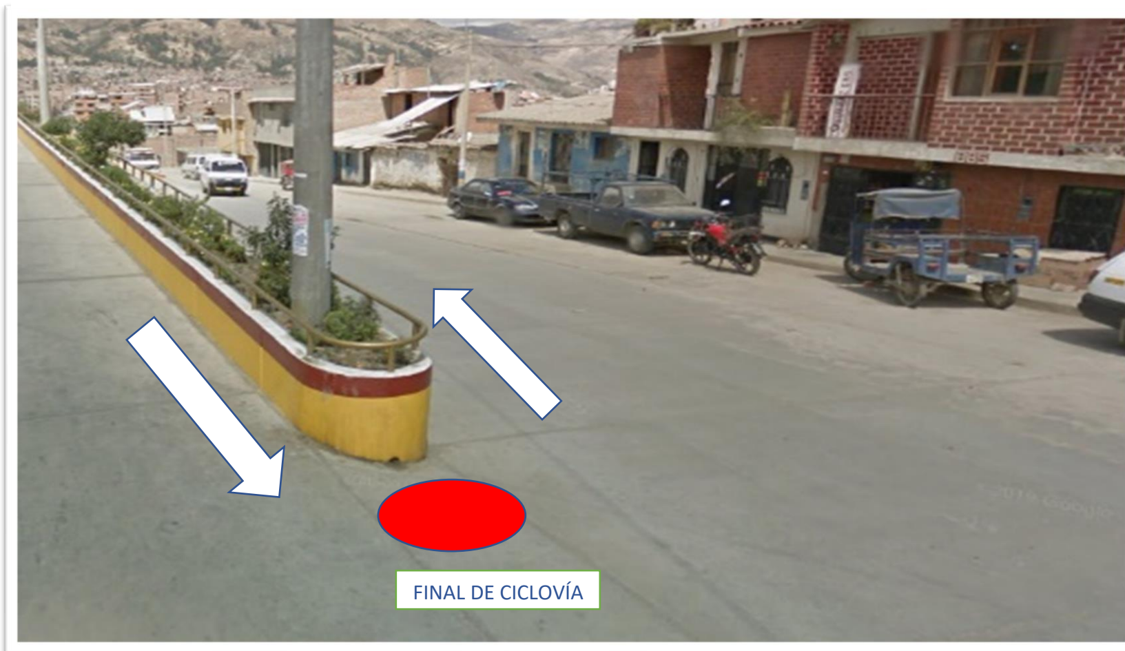
Figura 5: Se muestra una vista panorámica en el cual se muestra un punto rojo el cual se encuentra en la intersección de la Avenida Confraternidad Internacional Este con el Jr. Augusto B. Leguía, el cual representa el final de la ciclovía.
