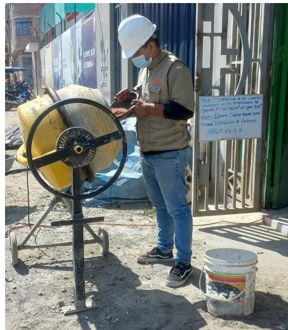
Foto 12: preparación de concreto
