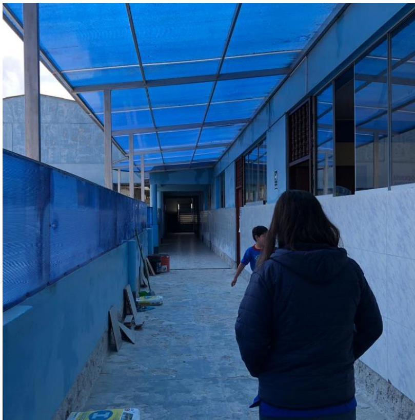
Improvisación de material que dificulta la exploración visual.
