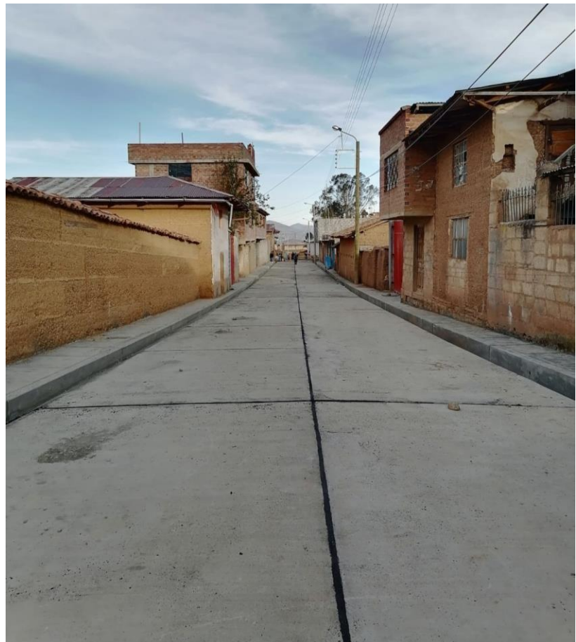
CULMINACION DEL PAVIMENTADO DEL TRAMO CALLE JUNIN-CALLE PIURA
