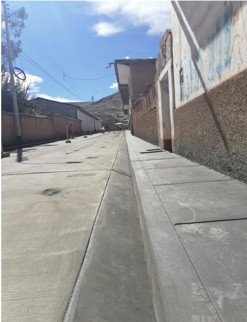
LIMPIEZA GENERAL PARA SU RESPECTIVO CELLADO EN LAS JUNTAS DE CONTRACCION
