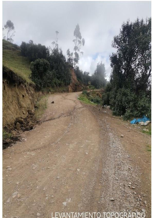
FOTO N° (6) en la fotografía se observa cunetas en mal estado, no se le hace mantenimiento.
