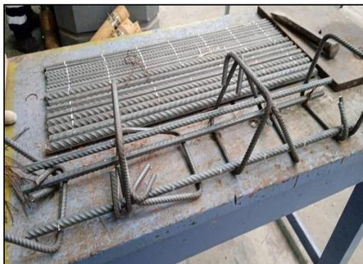
**Imagen 5.** Armado de las vigas con acero.
