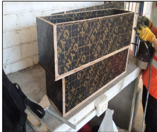
**Imagen 4.** Elaboración del encofrado.
