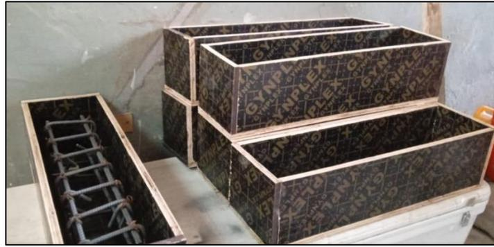
**Imagen 6 y 7.** Encofrado de viga y vaciado de probeta cilíndrica.
