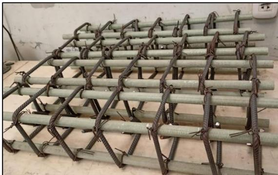
**Imagen 16.** Armado de viga con fibra de vidrio.
