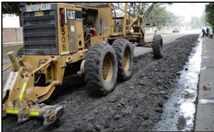
Figura 2. Estabilización de suelo aplicando ceniza vegetal
