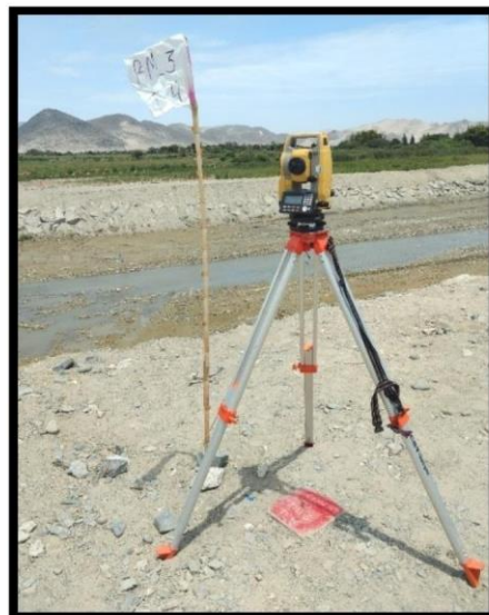
Foto: 2 SE OBSERVA A ESTACION TOTAL UBICADA EN EL BM-3 COORDENADAS UTM: 8975292.100 N 782273.00 E 55.00. Z
