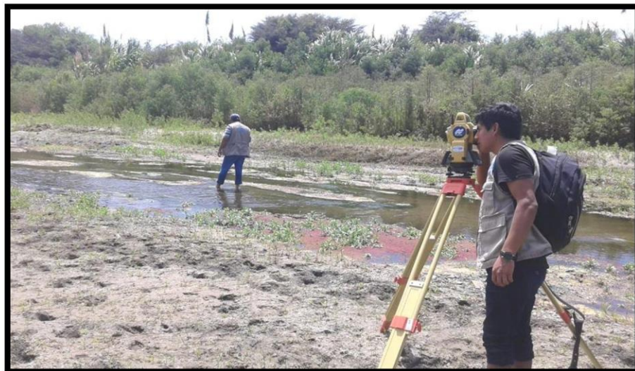
Foto: 6 SE OBSERVA EL LEVANTAMIENTO TOPOGRAFICO EN LA Prog. 4+600
