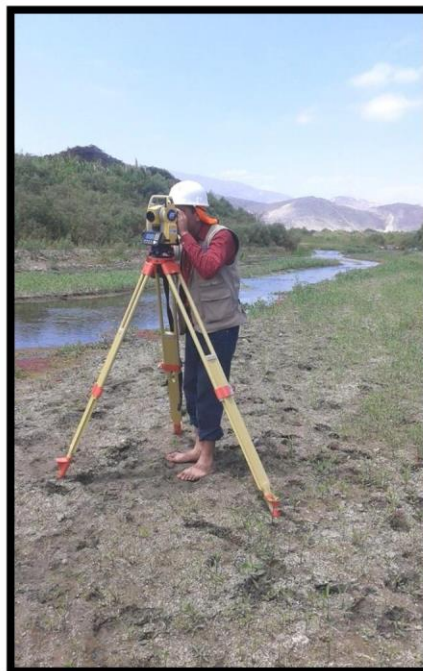
Foto: 4 SE OBSERVA EL LEVANTAMIENTO TOPOGRAFICO EN LA Prog. 3+400
