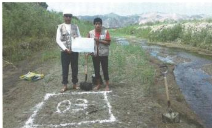
En la imagen se observa la zona donde se realizará el ensayo, puente huambacho.
