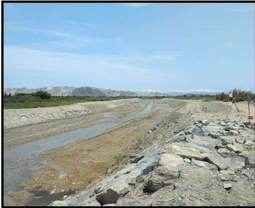
Foto: 01 SE OBSERVA Prog. 0+000 a Aguas Abajo.
