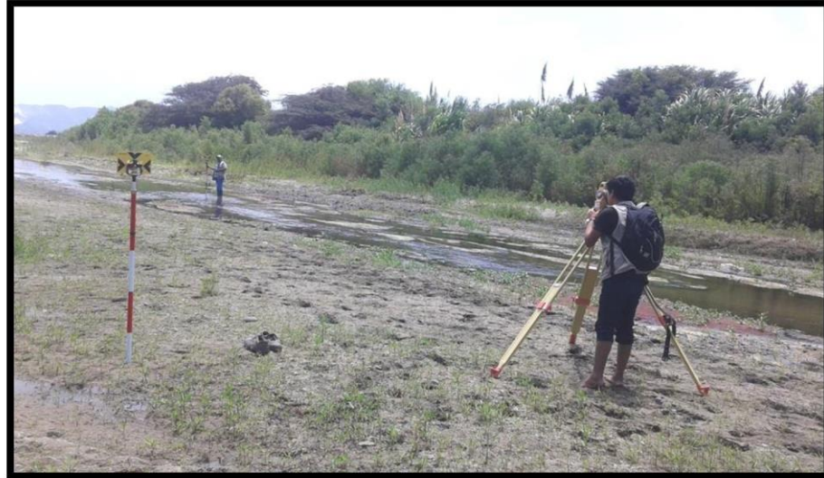
Foto: 5 SE OBSERVA EL LEVANTAMIENTO TOPOGRAFICO EN LA Prog. 4+600
