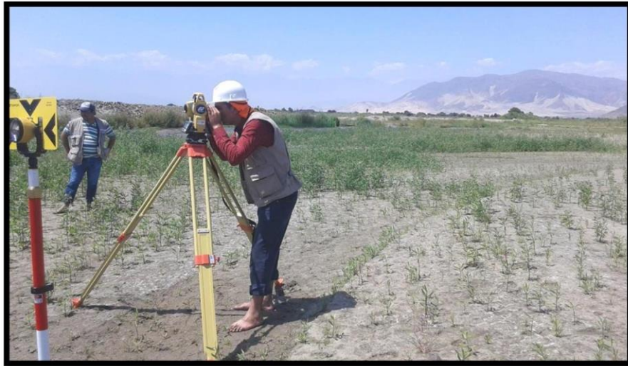
Foto: 3 SE OBSERVA EL LEVANTAMIENTO TOPOGRAFICO EN LA Prog. 2+500
