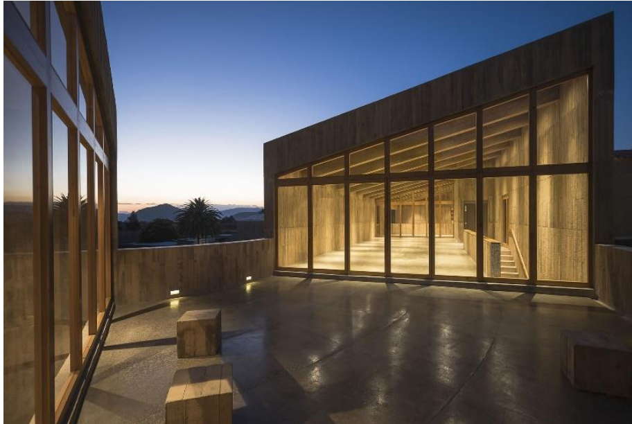
Figura 25: Vista interna del edificio principal y secundario, 2017 recuperado de http://productora-df.com.mx/project/centro-cultural-comunitario-teotitlan-del-valle/
