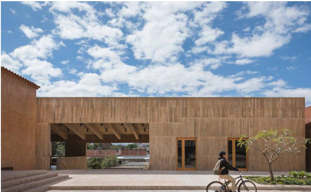
Figura 22: Vista frontal del Centro Cultural Comunitario, 2015 recuperado de http://productora-df.com.mx/project/centro-cultural-comunitario-teotitlan-del-valle/
