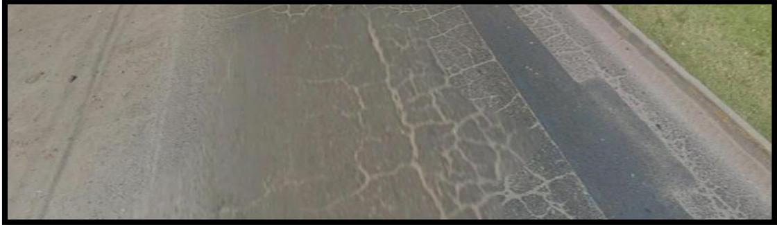
*Fotografía de asfalto con presencia de fallas múltiples y afloramiento de materiales.*
