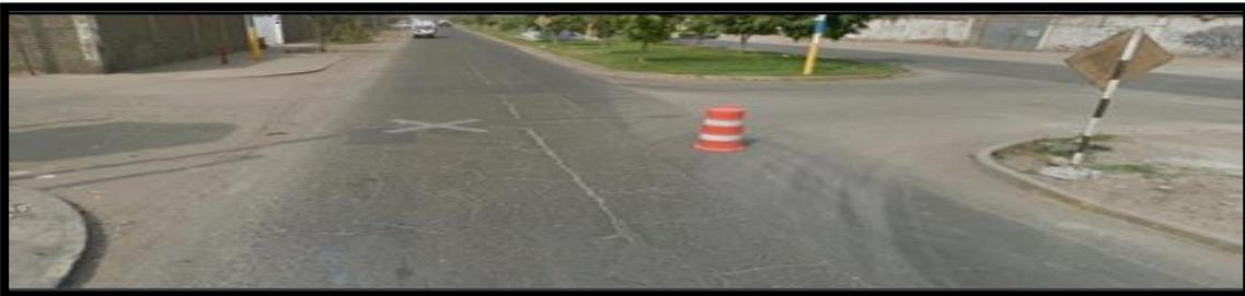
*Fotografía de asfalto con grieta longitudinal.*
