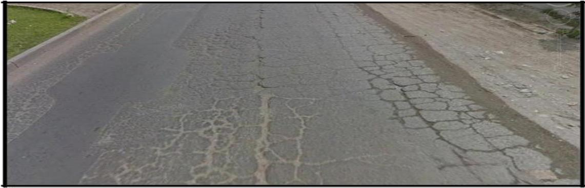
*fotografía de asfalto con presencia de agrietaciones profundas al nivel de carpeta.*
