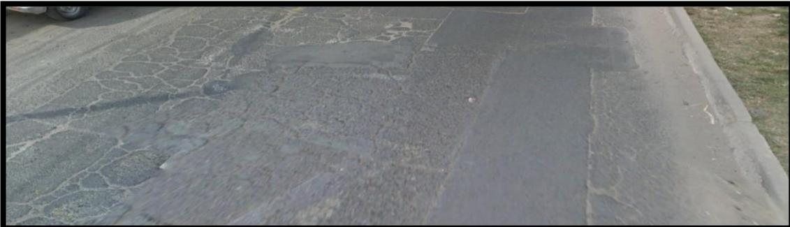
*Fotografía de asfalto con presencia de parche y grietas longitudinales*
