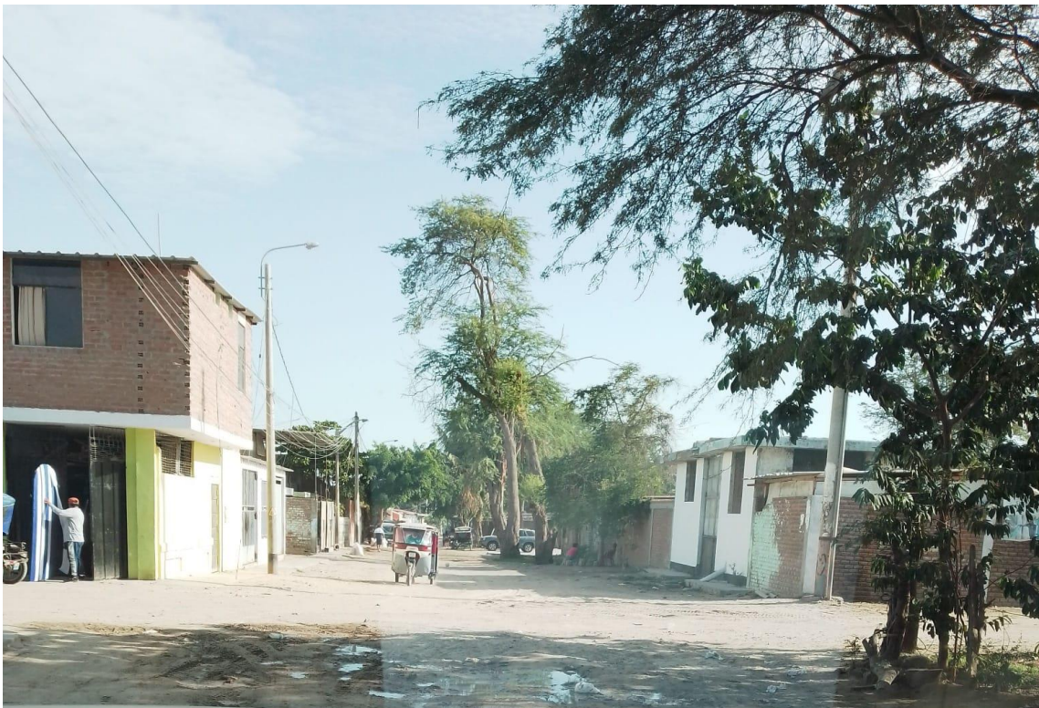
Figura: 2 Estado natural de las vías urbanas.
