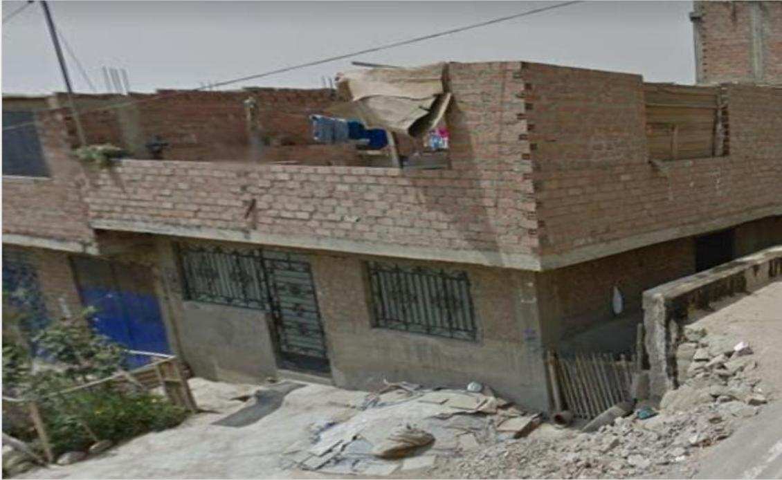
**Figura 43.** Ladrillo pandereta utilizando en la vivienda V3.
